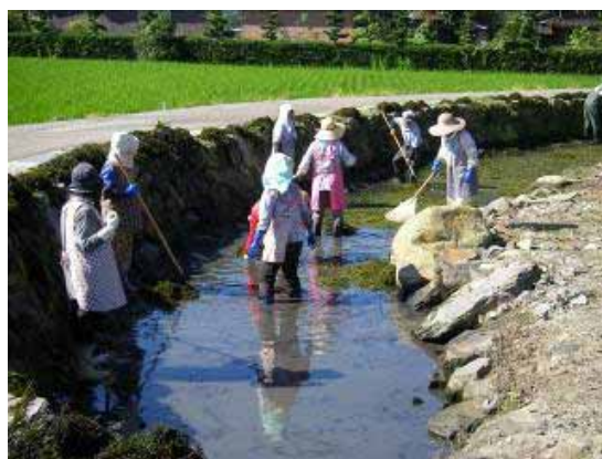
自然石で整備された護岸沿いの清掃作業
